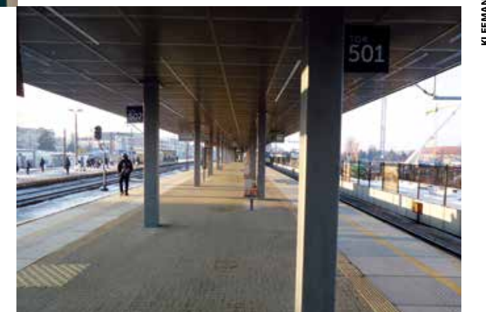
Railway stations Estaciones de tren
